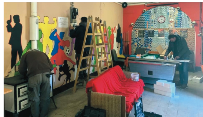
Zajlik az infrafűtés felszerelése
