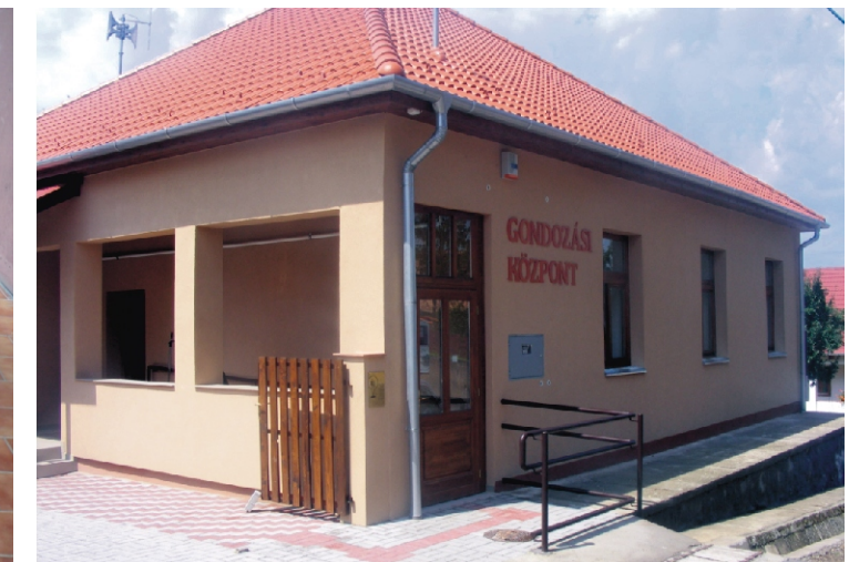
A felújított Gondozási Központ
