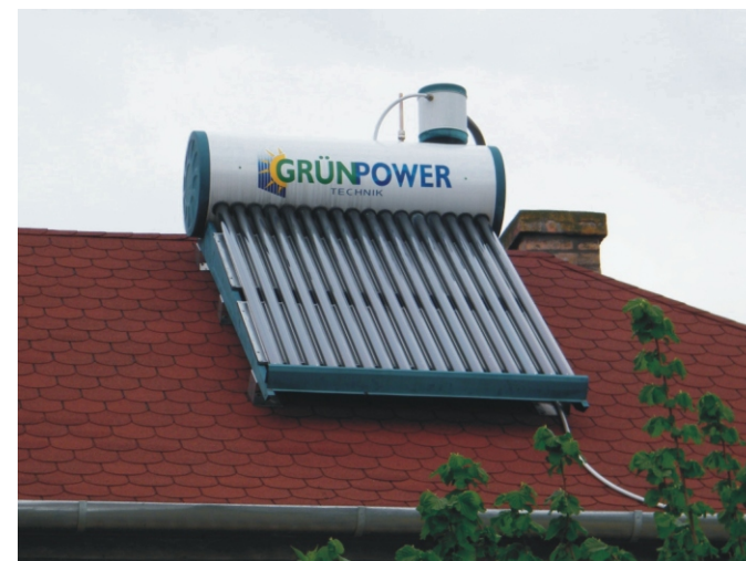
A napkollektoros tartályt a tetőre kell felszerelni
