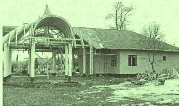
A képen még javában tart a ravatalozó felújítása, melynek munkálatai a tervezett 2006.márc.31-re is fejeződnek.
