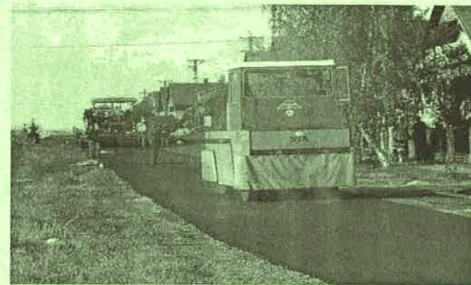
ASZFALT BURKOLATOT KAP A BEM APÓ ÚT. A csatornahálózat kiépítését követően a leginkább tönkrement, megsüllyedt út felújítását tervek szerint a következő években, hasonló technológia alkalmazásával követi a többi út felújítása is. A munkálatokat a HE-DO Kft. végzi településünkön.
